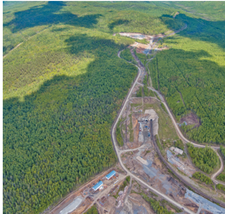
Строительство Керакского тоннеля в Амурской области, фото: www.uk-bsm.ru www.bsmuk.ru
