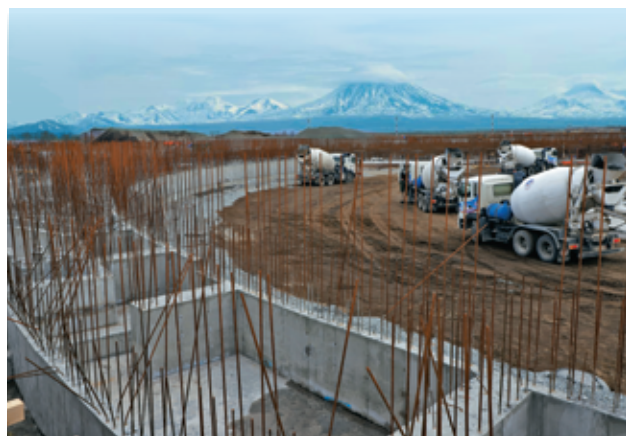
Стройплощадка терминала аэропорта Елизово www.kamgov.ru
